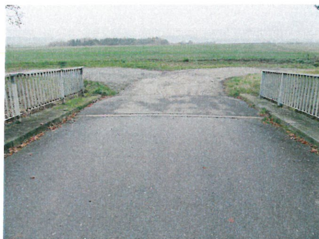
Obr. 32: MZ na západní straně mostu.
