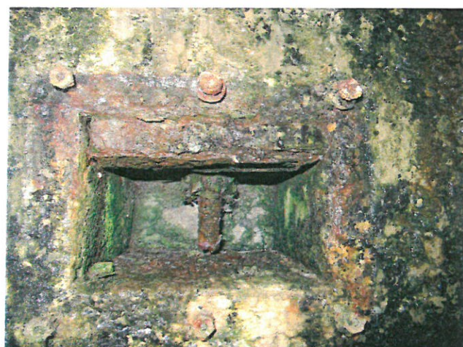
Obr. 22: Kotva tahového ložiska v úl. prahu.
