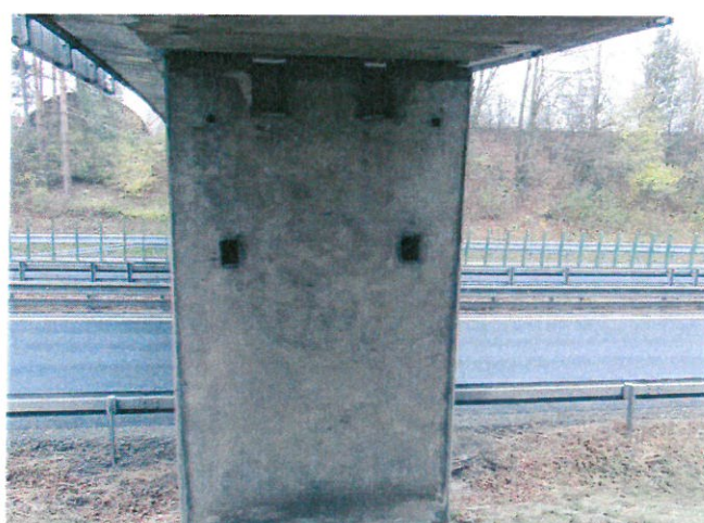
Obr. 12: Západní stěnový pilíř.
