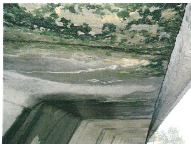
Obr. 28: Zatékání na NK.
