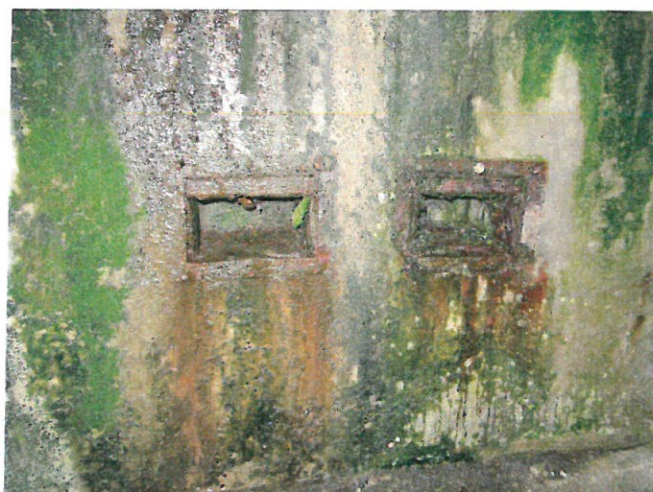
Obr. 8: Roznášecí ocelové desky tahových ložisek.
