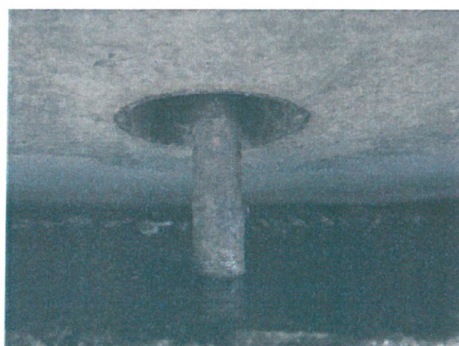
Obr. 6: Tyč tahového ložiska na západní opěře, voda na úložném prahu.
