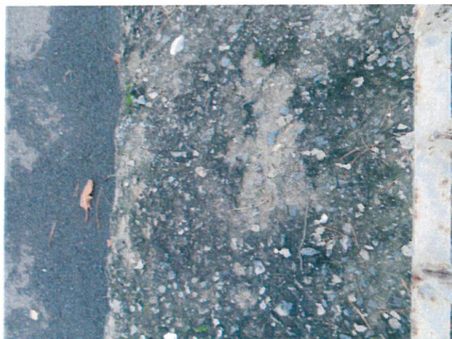
Obr. 48: Povrchový mrazový rozpad monolitické římsy na křídle.
