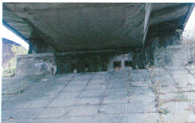
Obr. 15: Východní žešovská opěra.
