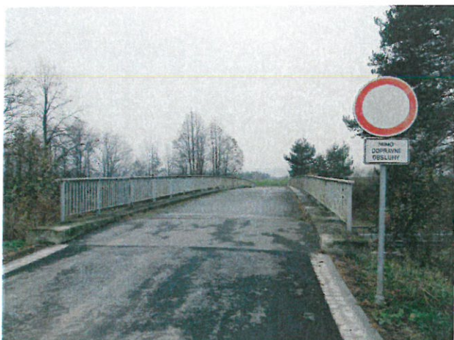
Obr. 49: Pohled na most s dopravní značkou.
