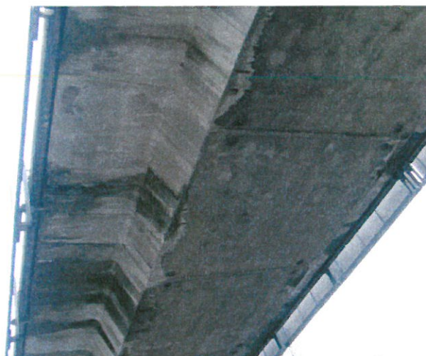
Obr. 26: Silné zatékání spárami v římsách na povrch NK.
