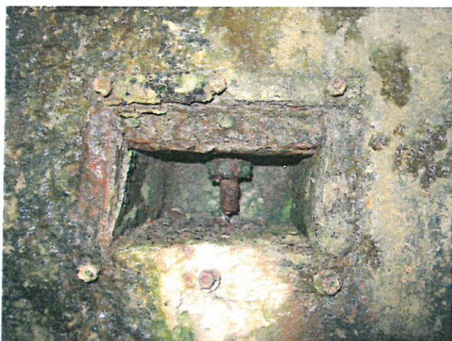
Obr. 19: Kotvy tahových ložisek v úl. prahu.
