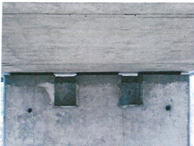
Obr. 13: Detail západního stěnového pilíře.
