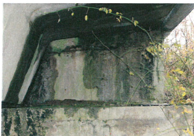
Obr. 16: Zatékání na líc opěry.
