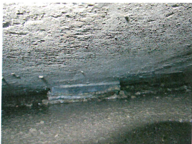
Obr. 4: Ložisko na západní opěře.
