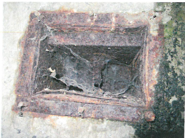
Obr. 19: Kotvy tahových ložisek v úl. prahu.
