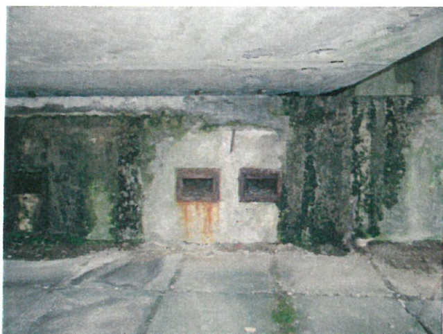
Obr. 17: Kotvy tahových ložisek v úl. prahu.
