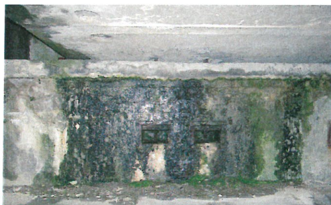
Obr. 16: Zatékání na líc opěry.
