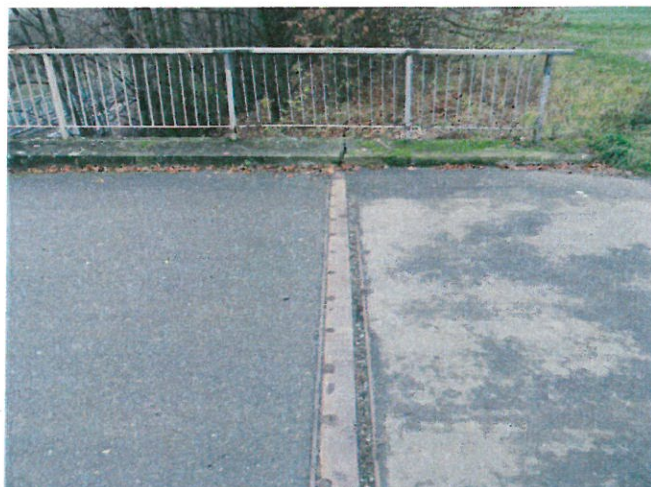
Obr. 34: Detail MZ nad západní opěrou.
