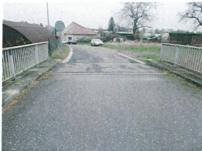
Obr. 44: Mostní závěr nad východní (žešovskou) opěrou.
