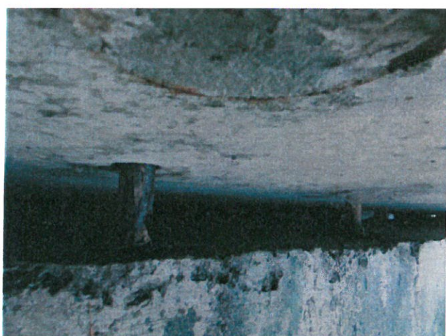
Obr. 5: Tyč tahového ložiska na západní opěře.
