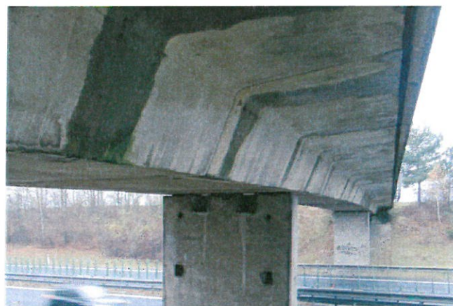
Obr. 26: Silné zatékání spárami v římsách na povrch NK.
