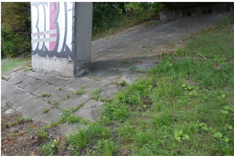
Obr.E62-44 Dlážděný svah při lici 4. podpěry, polní opěry. Pohled zprava doleva a ve směru staničení do pole,
