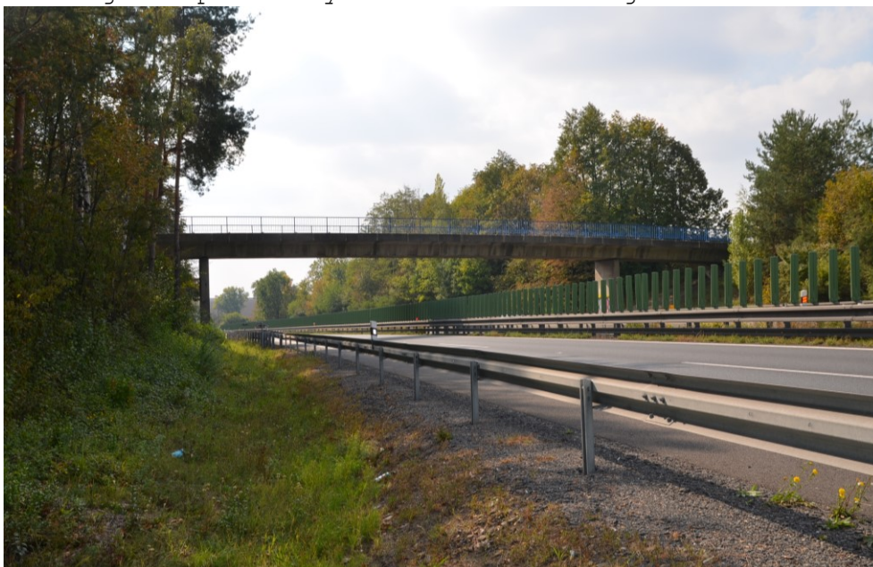
Obr.E62-04 Část pravé, prostějovské fasády mostu. Pohled zprava doleva, ve směru přemost. dálnice D46 Olomouc - Vyškov,
