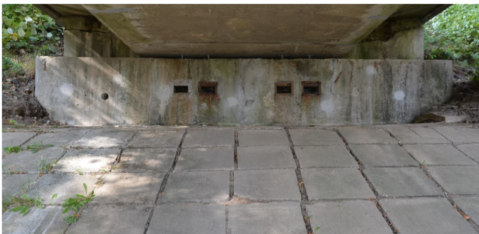
Obr.E62-08 Čtvrtá podpěra, polní opěra. Pohled ve směru staničení k poli,
