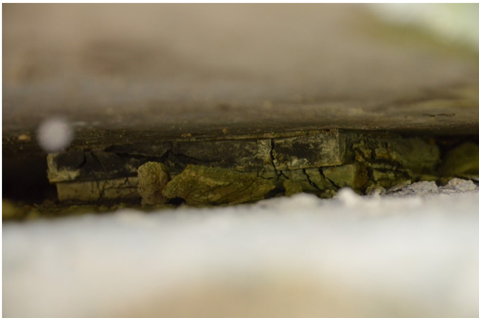
Obr.E62-37 Detail ložiska č.1 (levého) na 1. podpěře, žešovské opěře. Pohled do úložné spáry zleva doprava a proti směru staničení k Žešovu,
