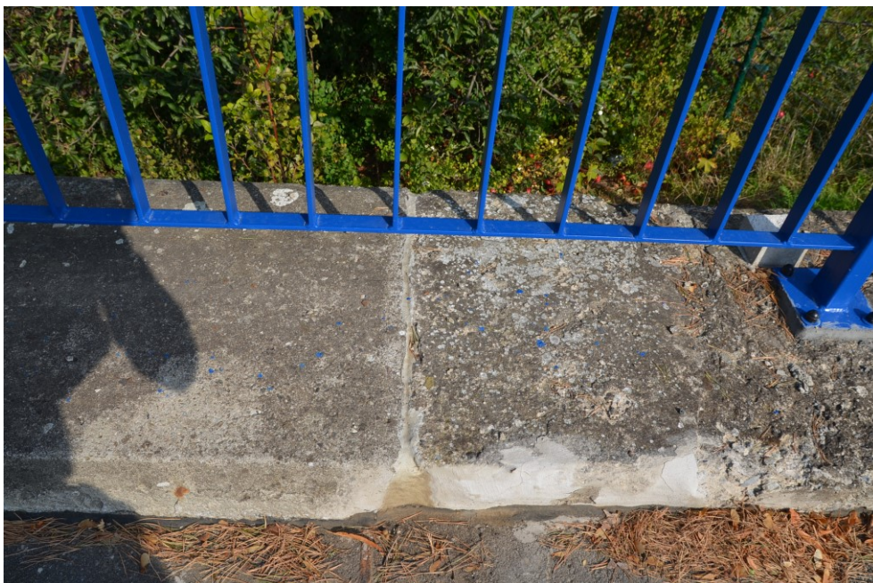
Obr.E62-28 Mostní závěr v pravostranné římsě nad 1. podpěrou, žešovskou opěrou. Pohled zleva doprava a dolů,
