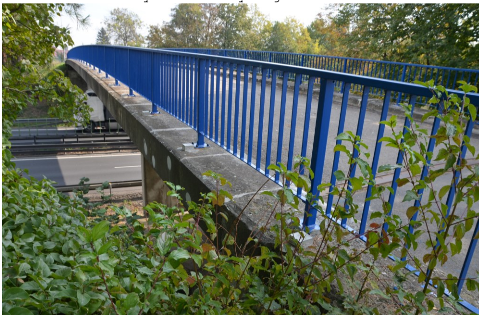
Obr.E62-24 Pravá fasáda NK ve 2. a 3. poli. Pohled proti směru staničení a zprava doleva,
