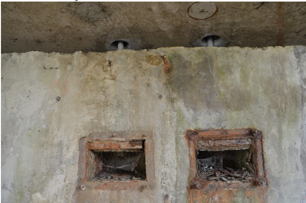
Obr.E62-36 Detail kotvení konce NK do 4. podpěry, polní opěry. Dvojice kotvicích tyčí (3., 4.) pod pravou komorou dvojkomorového trámu. Pohled ve směru staničení dopole,
