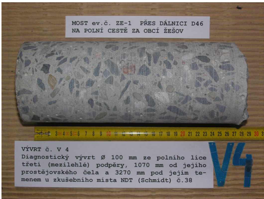
Obr. E62-4 VÝVRT č. V4. Diagnostický vývrt \varnothing 100 mm z polního líce třetí (mezilehlé) podpěry, 1070 mm od jejího prostějovského čela a 3270 mm pod jejím temenem, u zkušební místa NDT (Schmidt) č.38.
