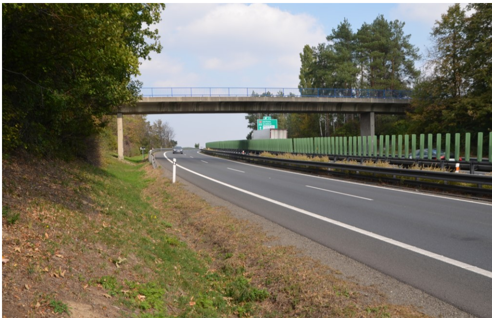
Obr.E62-03 Část levé, vyškovské fasády mostu. Pohled zleva doprava, ve směru přemostované dálnice D46 Vyškov - Olomouc,
