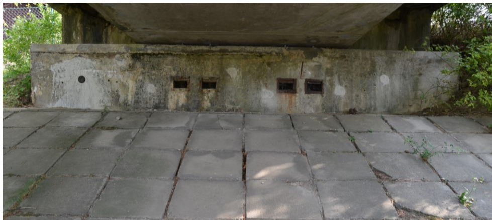
Obr.E62-05 První podpěra, žešovská opěra. Pohled proti směru staničení k Žešovu,
