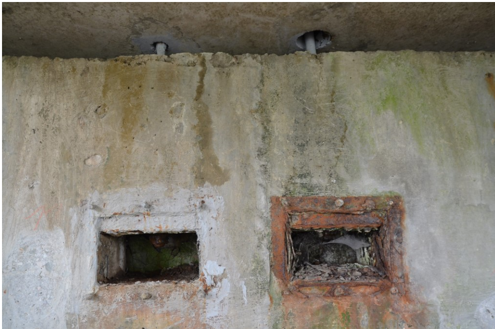
Obr.E62-35 Detail kotvení konce NK do 4. podpěry, polní opěry. Dvojice kotvicích tyčí (1., 2.) pod levou komorou dvojkomorového trámu. Pohled ve směru staničení do pole,
