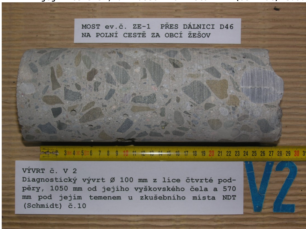
Obr. E62-2 VÝVRT č. V2. Diagnostický vývrt \varnothing 100 mm z líce 4. pod- pěry, 1050 mm od jejího vyškovského čela a 570 mm pod jejím temenem, u zkušebního místa NDT (Schmidt) č.10.
