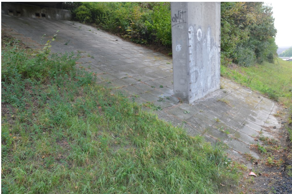
Obr.E62-43 Dlážděný svah při lici 1. podpěry, žešovské opěry. Pohled proti směru staničení k Žesovu a zprava doleva,
