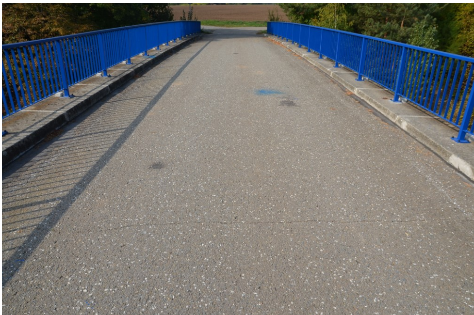
Obr.E62-39 Vozovka, římsy a zábradlí na druhé polovině mostu. Pohled přibližně z poloviny rozpětí, ve směru staničení do pole,
